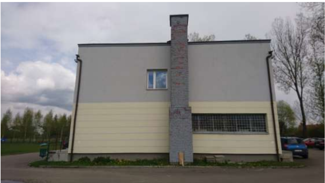
Widok elewacji południowej obiektu
