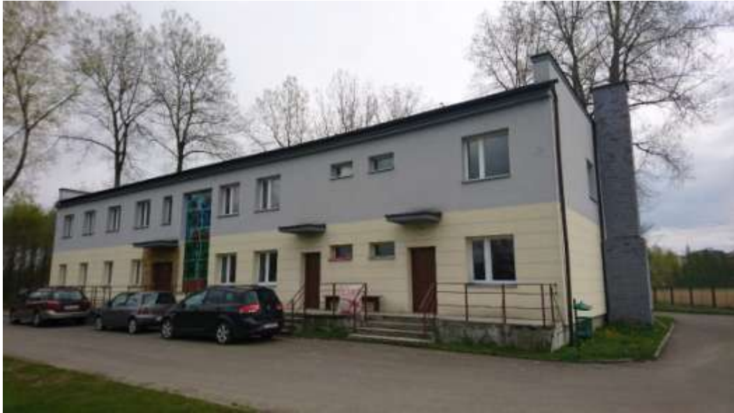
Widok budynku od strony zachodniej
