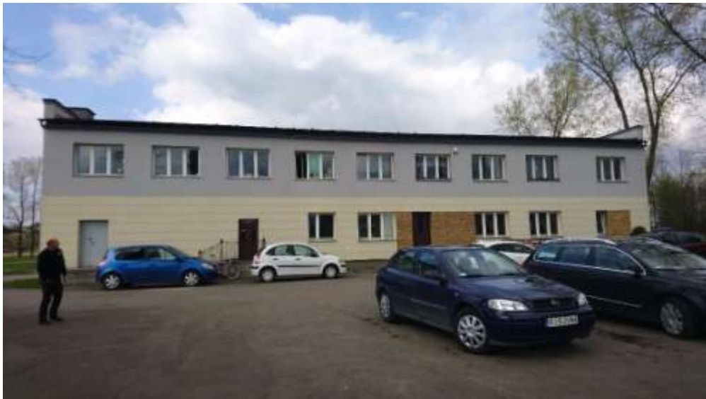
Widok budynku od strony wschodniej
